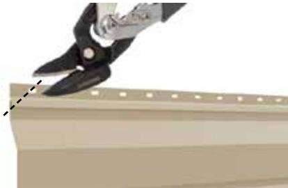
Первую планку сайдинга «Корабельная доска» заводят под нижнюю часть начальной планки, обеспечивая замковое сцепление, верхнюю часть сайдинга крепят к направляющим саморезами 4.2х16 в перфорированные отверстия.
